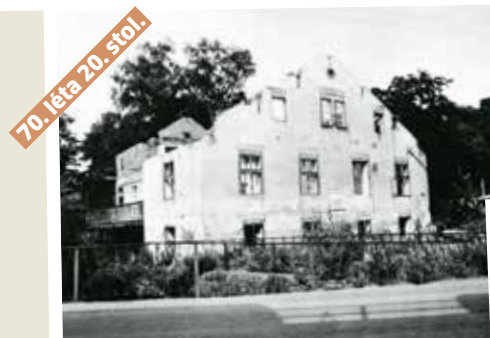
Rekonstrukce krovu Braunerova mlýna, 70. léta 20. stol.
