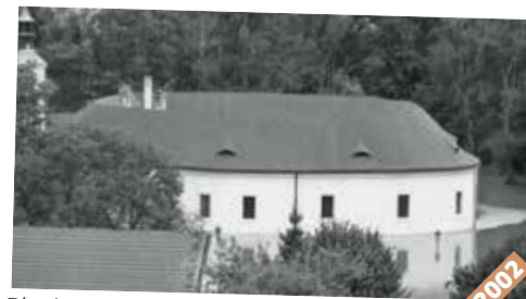
Zámek a přilehlé budovy při povodni v srpnu 2002
