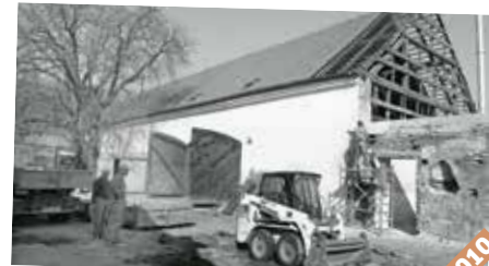
Dostavba a rekonstrukce stodoly v areálu zámku, 8. 4. 2010
