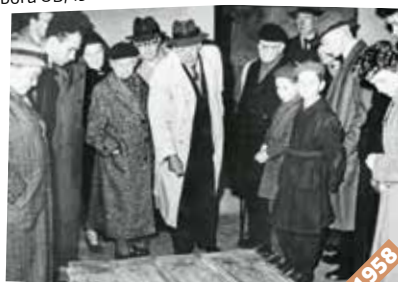
Výklad architekta Pavla Lyera k objevenému záklapovému stropu v prostorách zámku, 27. 4. 1958
