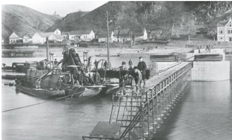
Stavba roztockého jezu (cca 1895)
