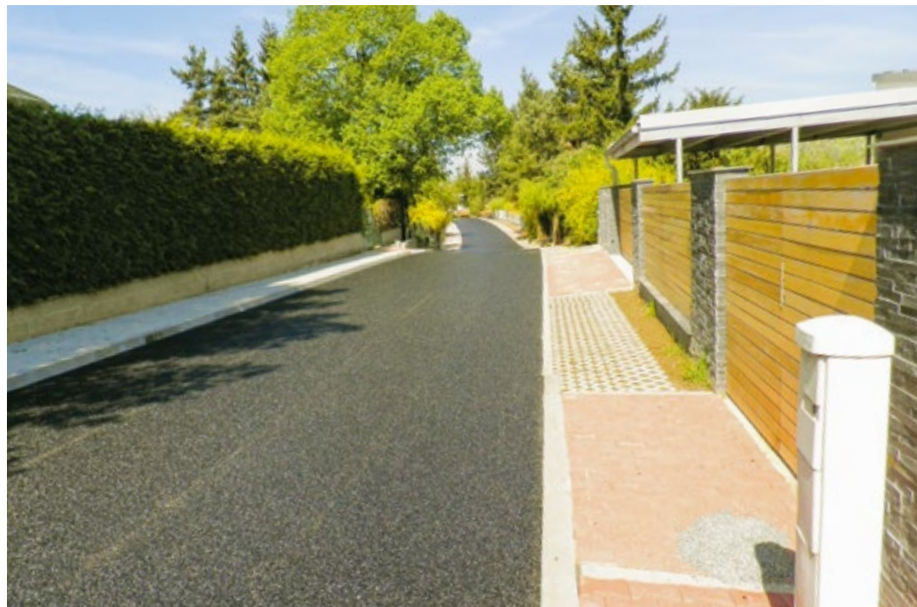
Nový povrch ulice Třebízského.
