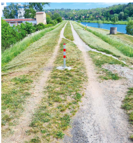
Závora na protipovodňové hrázi byla nahrazena sloupkem pro pohodlnější projíždění cyklistů
